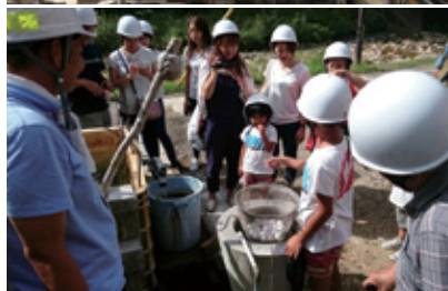
上：イスラエルから輸入したバイナリー発電設備。 この奥に温泉のタンクがある。 下：温泉卵を作って温泉熱を体感する アクティビティは、研修旅行のコンテンツとして人気
